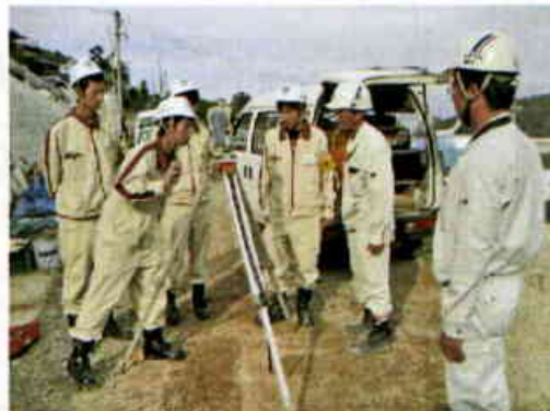
荒木組が施工する現場で実習する生徒ら
