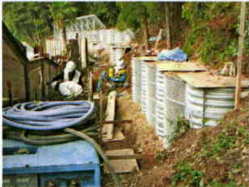
斜面地の狭隘(きょうあい)な状況下で 難しい作業を伴う現場
