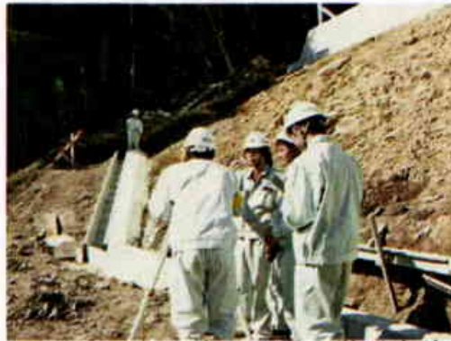
TSを用いた出来形測量を学ぶ生徒
