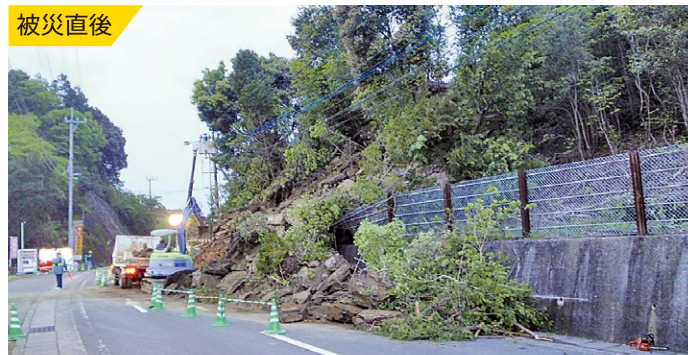
国道206号の災害復旧 [長崎市長浦町 / 平成22年災害] (写真提供: 長崎県)
