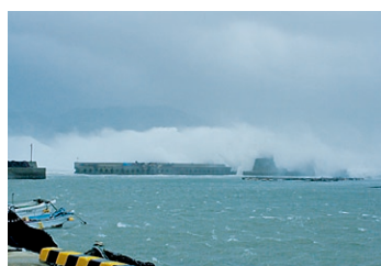
台風の高波からみんなを守る「防波堤」 (有川港 平成17年9月 台風14号) [新上五島町] (写真提供: 長崎県)
