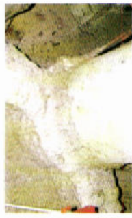
鉄骨耐火補壁
