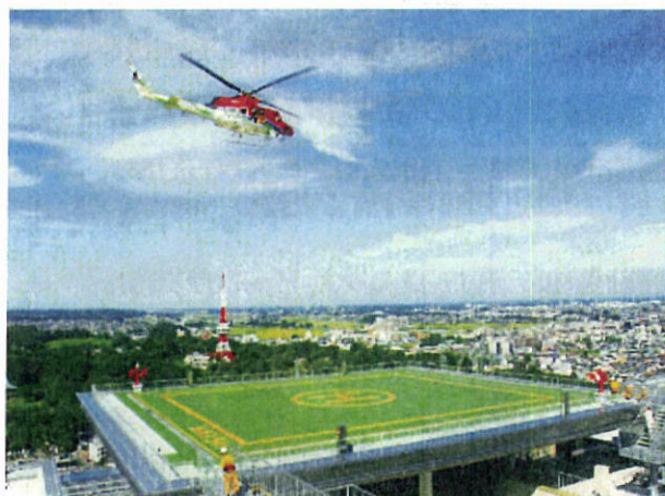
屋上ヘリポートの事例
