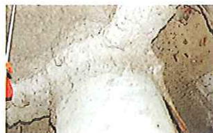
鉄骨耐火被覆
