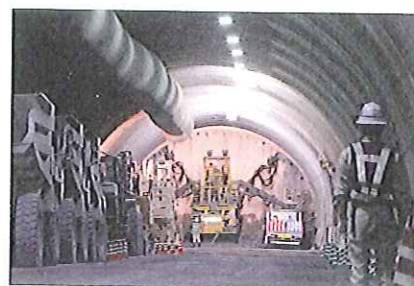
グラビア:新東名高速道路鳳来トンネル工事
