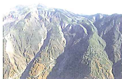
グラビア: 甚之助谷地すべり対策排水トンネル工事(甚之助谷)
