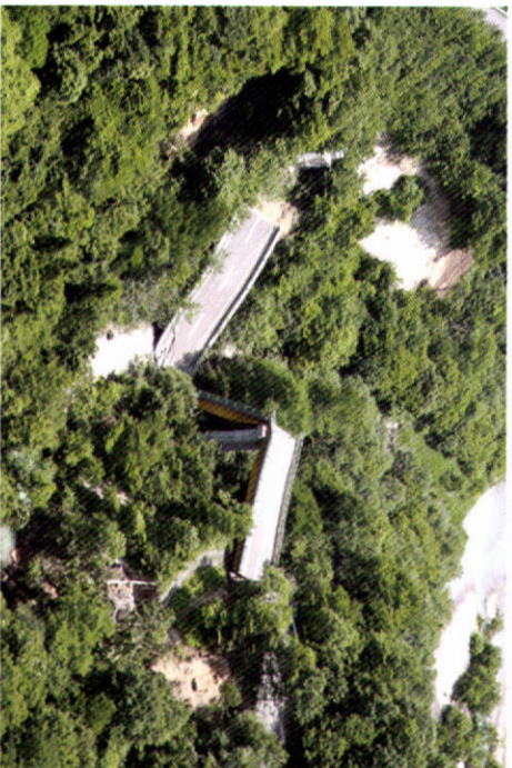
岩手・宮城内陸地震で落橋した祭時大橋(岩手県一関市)
