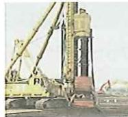
**原位置鉄粉混合(DIM 工法)**
