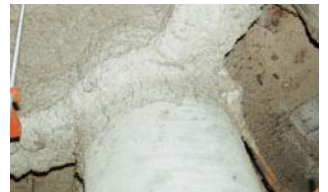
鉄骨耐火被覆
