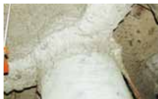
鉄骨耐火被覆
