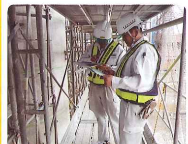
仮設安全監理者によるチェックリストに基づく足場の安全点検
