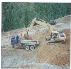
バックホウによる掘削積込作業
