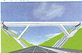
能越自動車道(七尾氷見道路) PC方柱ラーメン橋 (パシフィックコンサルタンツ(株))
