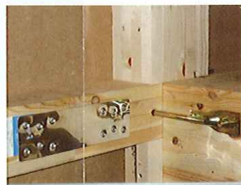
写真5 平金物と羽子板ボルトの固定状況
