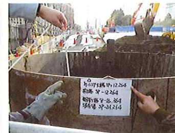
写真4 掘削深さの確認状況
