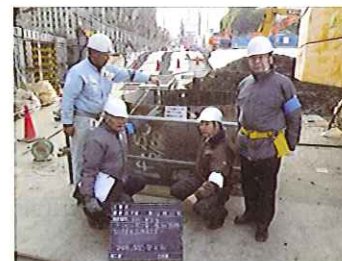
写真3 掘削深さの確認状況
