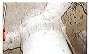
鉄骨耐火被覆
