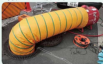
従来のファン式換気装置(送風機とダクト)
