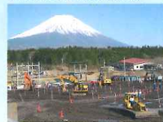
鉄骨躯体教材
