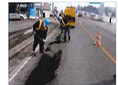
舗装版舗設作業
