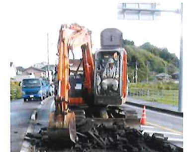
舗装版破碎作業
