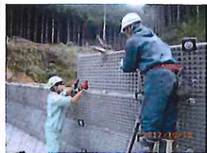
現場実習の様子(栃木県建設業協会)
