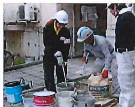
現場実習の様子(兵庫県建設業協会)
