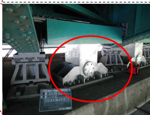
支承補強構造(橋軸直角方向)
