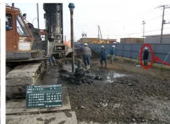
市監督員が現場で埋設完了を確認
