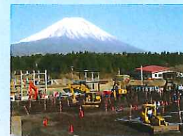
鉄骨躯体教材
