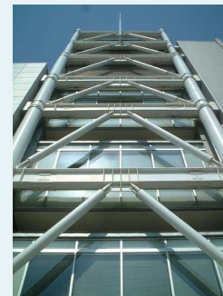
鋼材ダンパー (座屈拘束ブレース)
