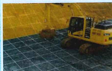
ICT 建機による施工
