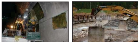
トンネルの修繕
