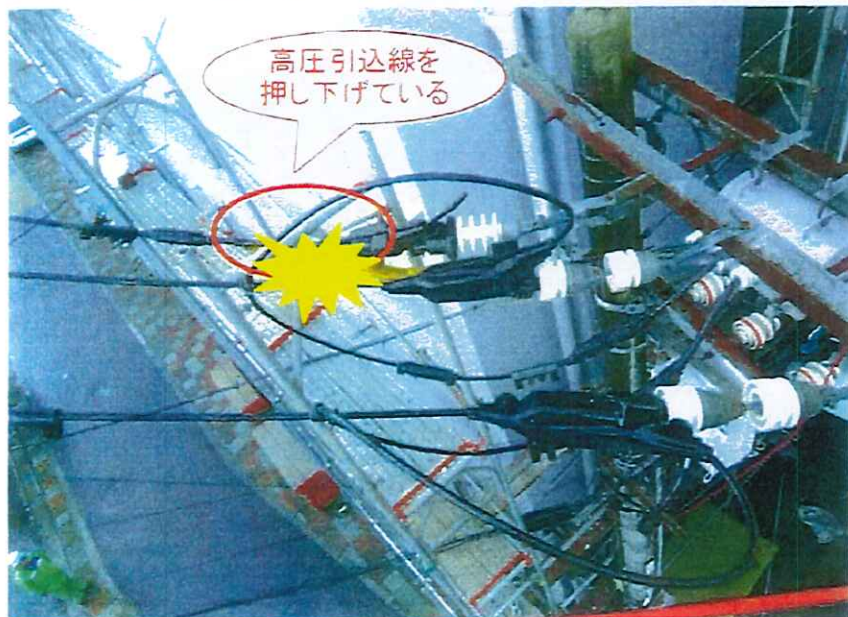
【高圧引込線と作業足場の状況】
