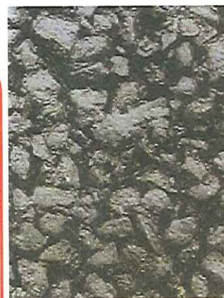
ポーラスアスファルト舗装 (排水性舗装)
