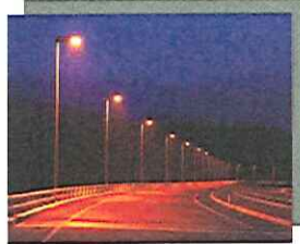
設置例:ナトリウム灯
