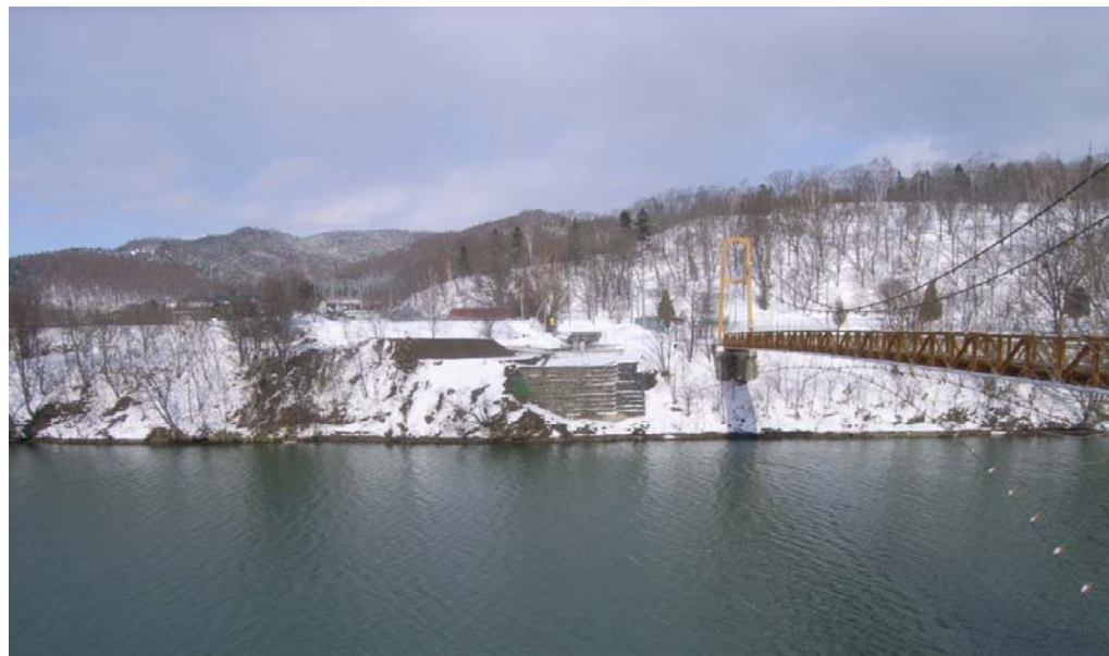
工事完了後の風景
