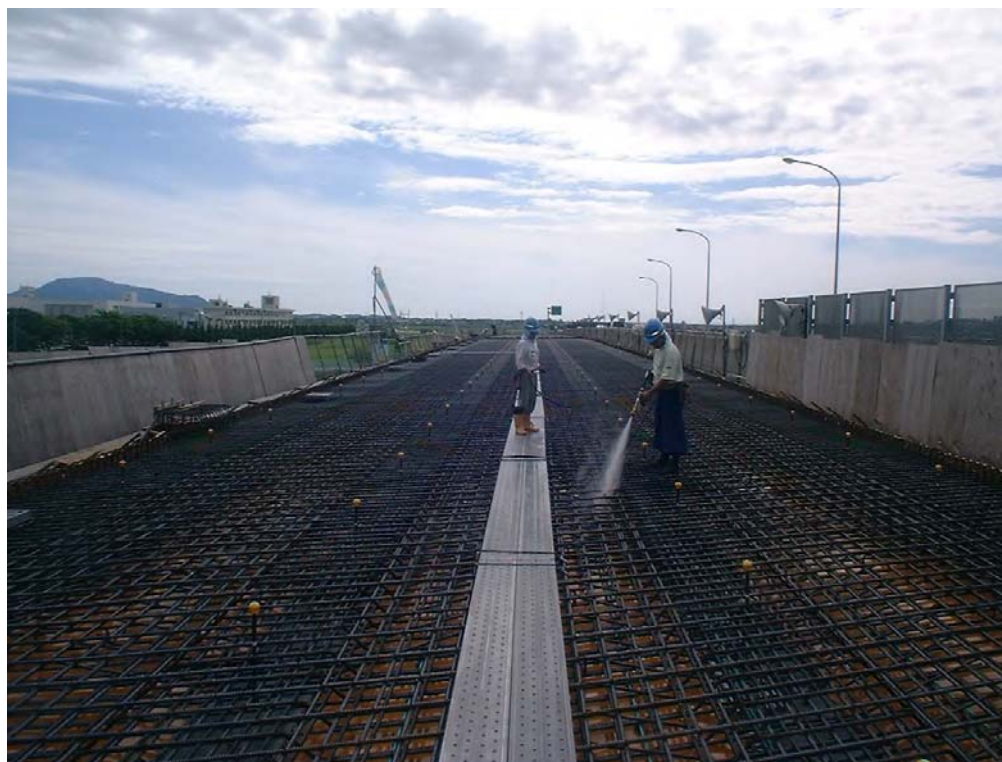
鉄筋・型枠散水状況
