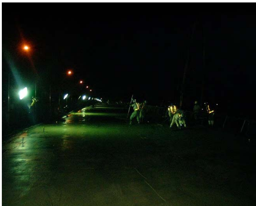
起点側打設状況
