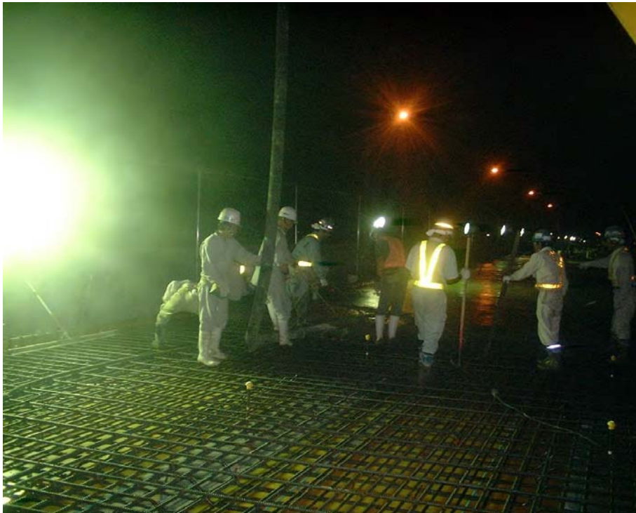
夜間打設状況
