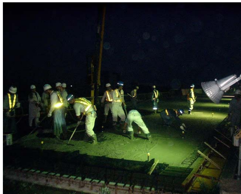
終点側打設状況
