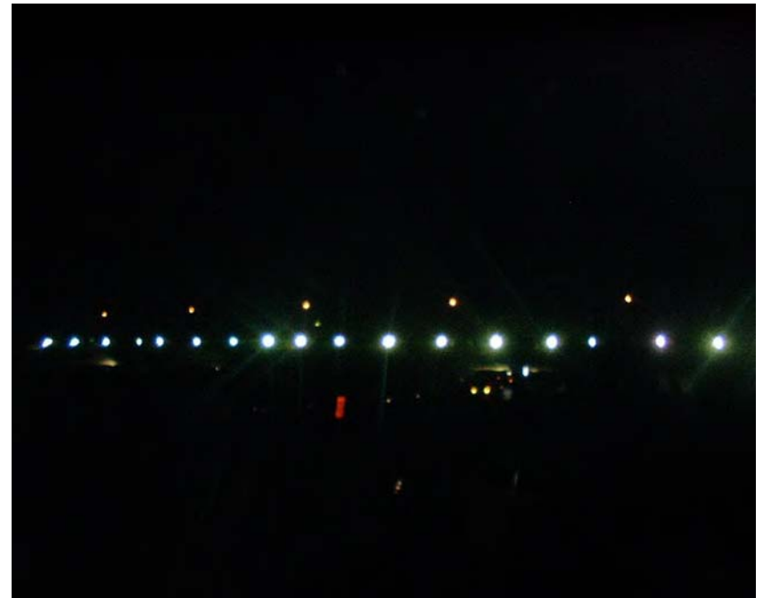
夜間照明点灯状況
