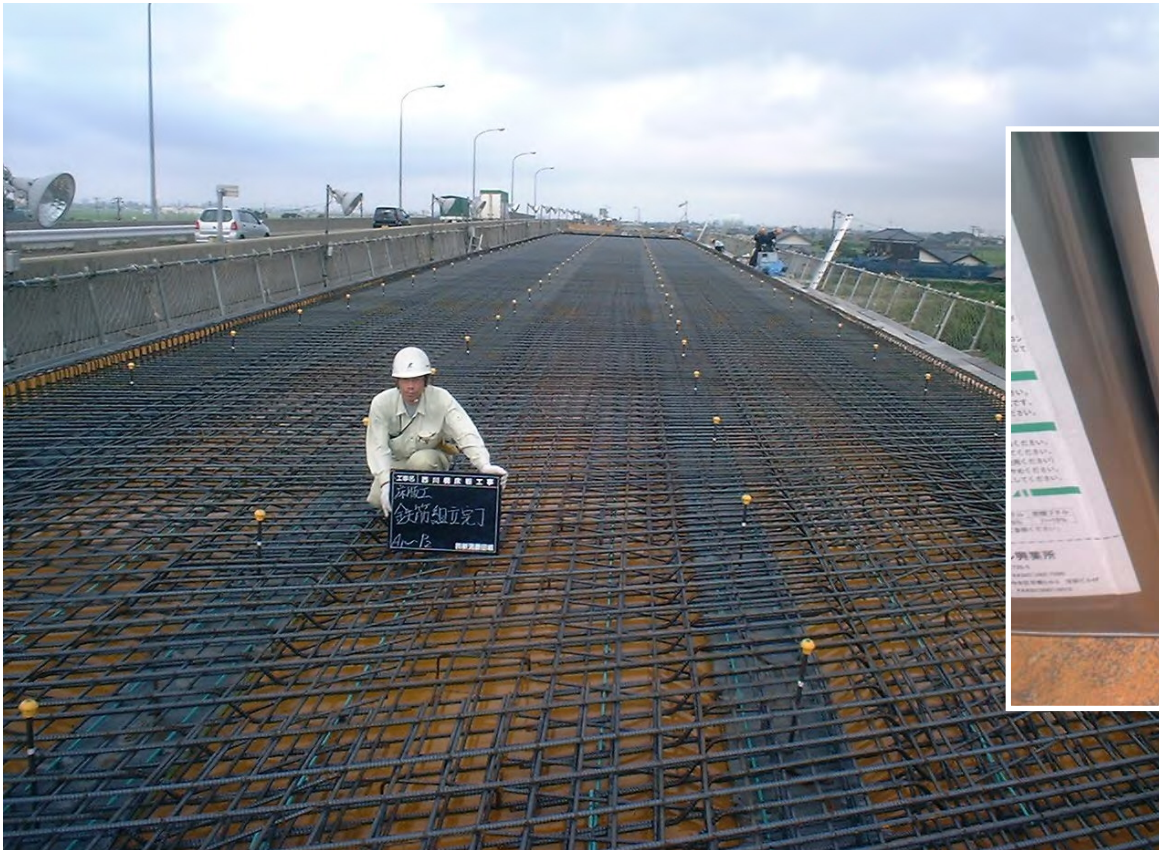
鉄筋組立完了
