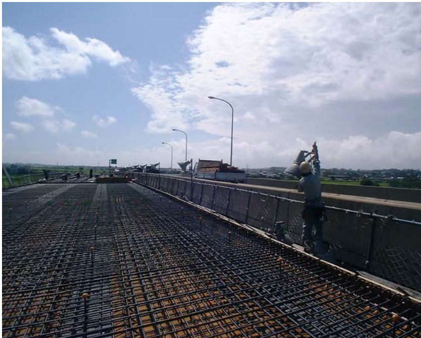
夜間照明設置状況
