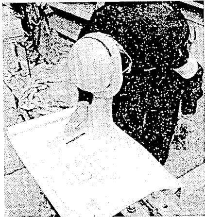
図面整合が問われ、現場での施工品質もクローズアップした
