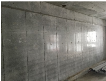
図20 脱型後(間仕切り壁)
