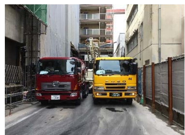
図7 生コン車2台付け状況
