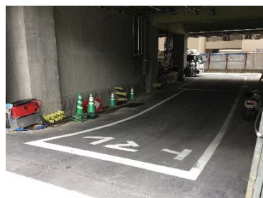
図6 スロープ形成状況
